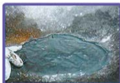
鉄表面の充填接着補修
