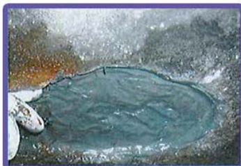
鉄表面の充填接着補修
