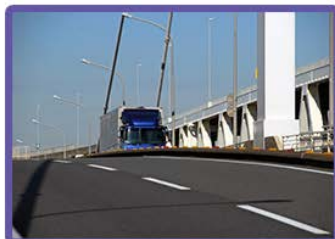
橋及び高速道路の鉄構造物や鉄塔
